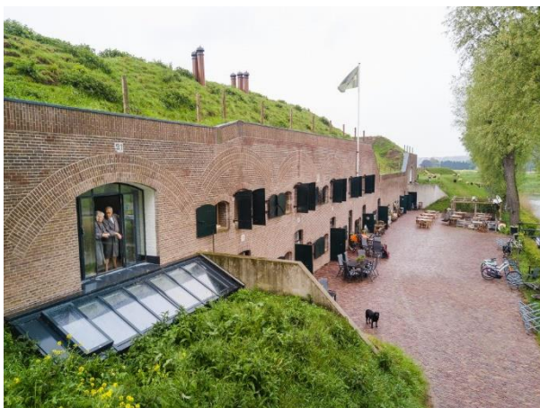
Ryc. 3 Fort Bakkerskil – widok elewacji koszar
