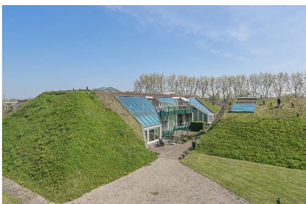
Ryc. 9 Fort Steurgat - widok elementu uzupełnienia kubatur para historyzującego
