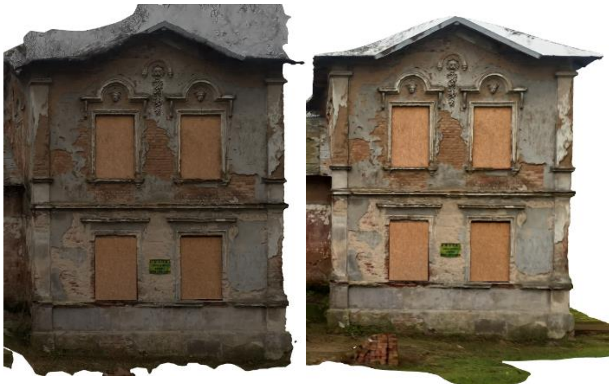
Rysunek 73 Fragment modelu dworu w Kliczewie Małym. Widok w programie ReCap Photo w trybie "Textured". Lewy model stworzony w programie Meshroom, prawy w programie ReCap Photo.
