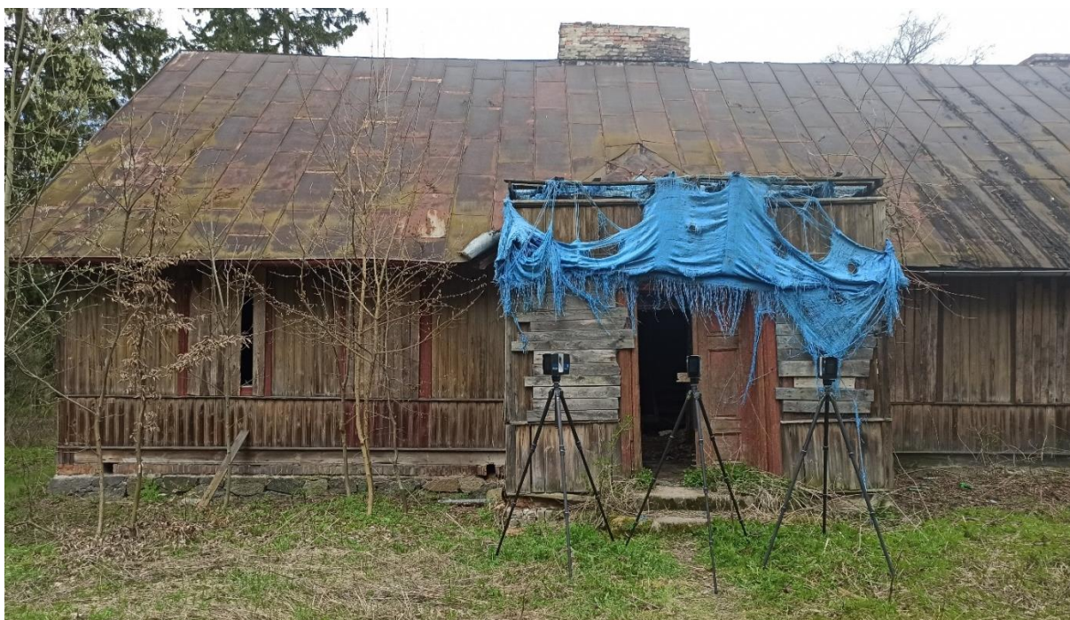
Rysunek 35 Widok na elewację frontową i stojące przed nimi 3 skanery Faro, którymi została przeprowadzona inwentaryzacja budynku, data wykonania zdjęcia: 2021-04-27, zbiory własne.
