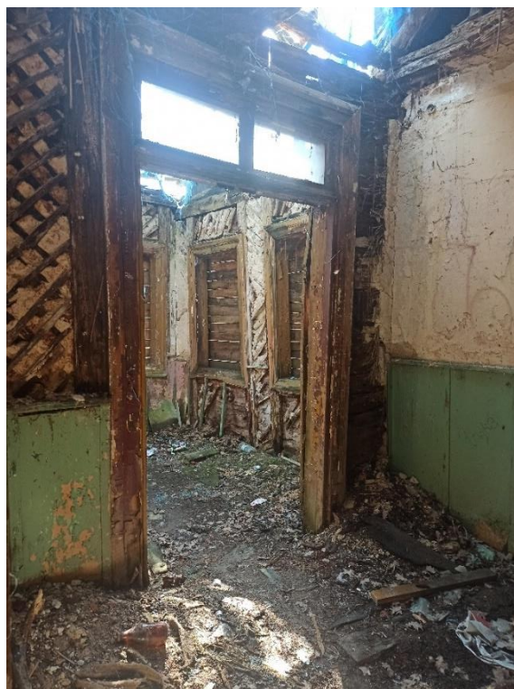
Rysunek 33 Widok na ganek z wnętrza budynku, data wykonania zdjęcia: 2021-04-27, zbiory własne.
