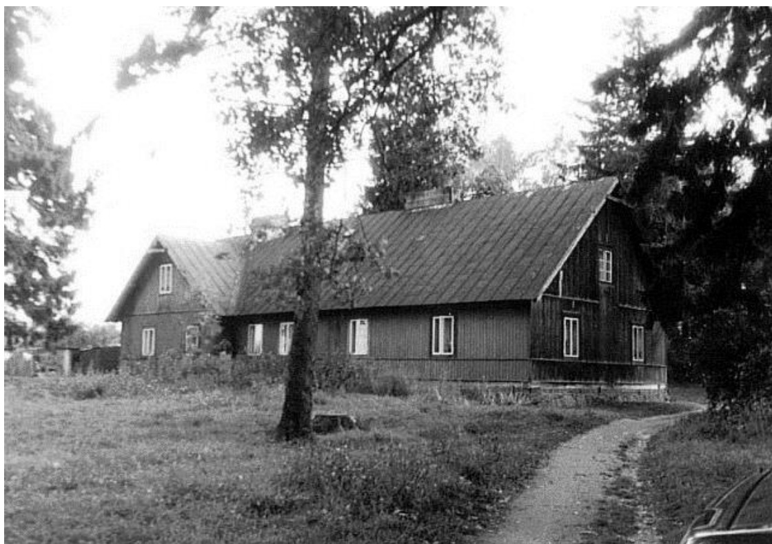
Rysunek 12 Tylna elewacja budynku, autor zdjęcia: Ryszard Małowiecki, 23.09.1996 r.
