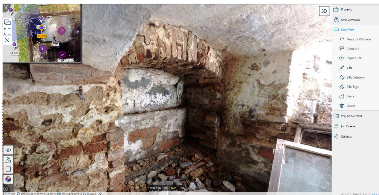
Rysunek 53 Widok zdjęcia sferycznego piwnicy w przeglądarce Faro WebShare z widocznym w lewym górnym rogu odniesieniem lokalizacji na rzucie.
