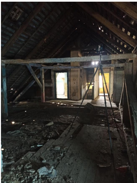
Rysunek 34 Skaner laserowy Faro w trakcie wykonywania pomiarów na poddaszu dworu w Nużewie, data wykonania zdjęcia: 2021-04-27, zbiory własne.
