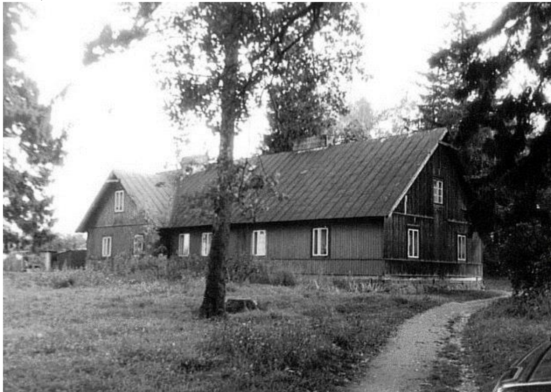
Rysunek 15 Tylna elewacja budynku, autor zdjęcia: R. Małowiecki, 23.09.1996 r.
