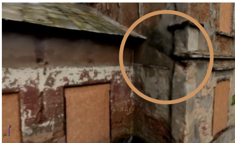
Rysunek 90 Fragment modelu dworu w Kliczewie Małym z widocznym miejscem styku dachu ganku z bryłą budynku. Miejsca takie stanowią odniesienie dla cyfrowej rekonstrukcji części obiektu, które nie istniały w trakcie pomiaru.
