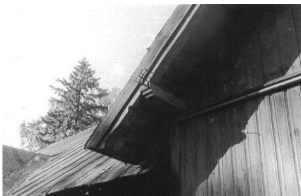
Rysunek 26 Fasada - fragment konstrukcji dachowej, autor zdjęcia: R. Małowiecki, 23.09.1996 r.
