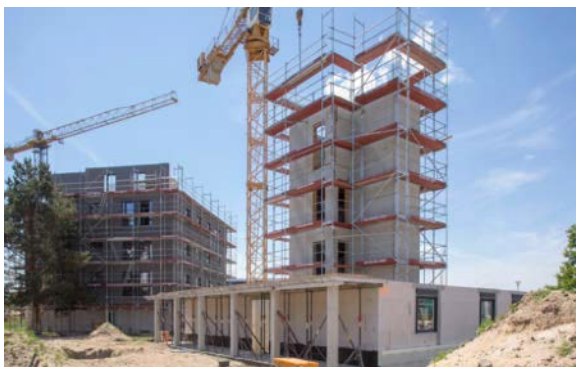
Fot. 3.12 Zespół budynków mieszkalnych UH – Urban Timber Construction przy Dolgenseestr. 32/33 z 2019 roku w Berlinie. Klatki schodowe.
