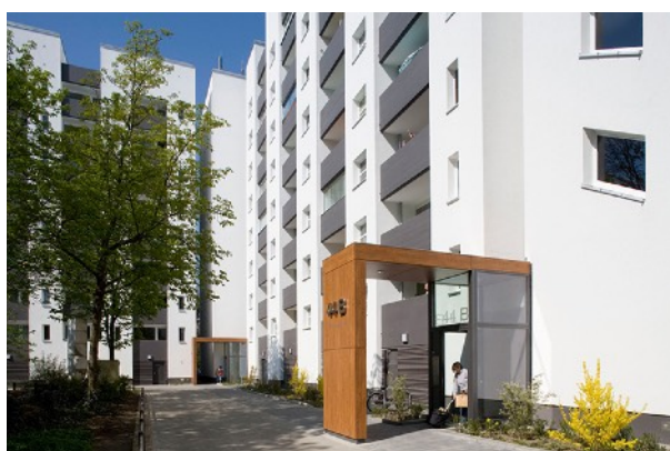
Fot. 3.32 Osiedle wielkopłytowe Märkisches Viertel. Zmodernizowane wejście do budynku. Źródło: [online] http://www.dahm-ai.de [dostęp: 12.22.2022]
