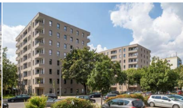
Fot. 5.12 Budynki mieszkalne przy Sewanstr. 20/22.
