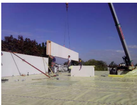
Fot. 3.27 Budynek mieszkalny VILLA NOVA w Warszawie. Fotografia z etapu montażu z uwidocznionym elementem prefabrykowanym. Źródło: [online] https://www.multicomfort.pl/essential_grid/apartamentowiec-polskawarszawa/ [dostęp: 22.12.2022]
