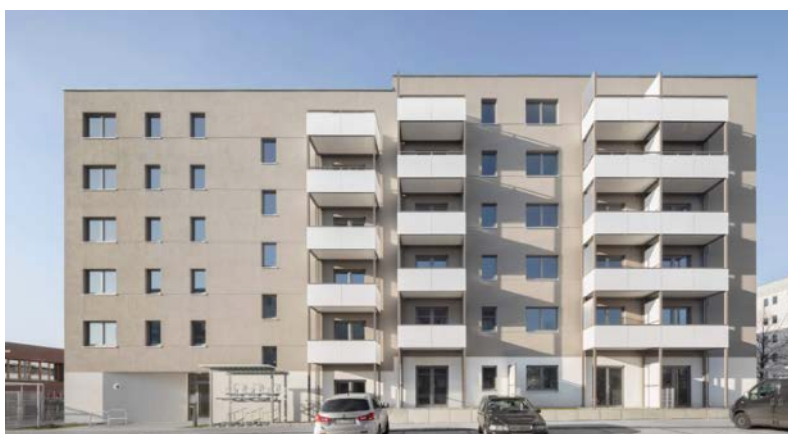
Fot. 3.3 Budynek mieszkalny TypenHaus Plus przy Schkeuditzer Strasse 28-36 w Berlinie. Elewacja. Źródło: [online] https://www.arnoldundgladisch.de/projekte/wohnen-typenhaus/ [dostęp: 22.12.2022]
