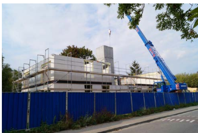
Fot. 3.26 Budynek mieszkalny VILLA NOVA w Warszawie. Fotografia z etapu montażu z uwidocznioną żelbetową klatką schodową. Źródło: [online] https://www.multicomfort.pl/essential_grid/apartamentowiec-polskawarszawa/ [dostęp: 22.12.2022]
