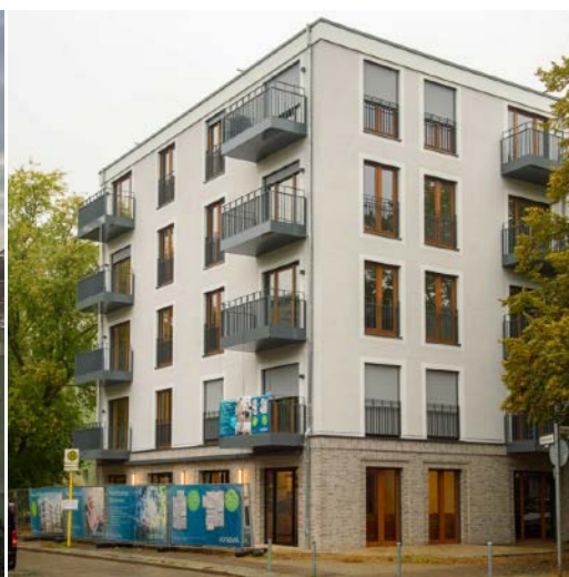
Fot. 3.18 Budynek mieszkalny na rogu ulic Amende- i Herbststr. w Berlinie. Elewacja. Źródło: [online] https://www.berliner-woche.de/reinickendorf/c-bauen/neubau-in-der-amendestrasse-entstand-in-holzbauweise_a324524#gallery=default&pid=377306 [dostęp: 20.11.2022]
