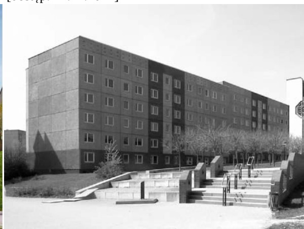
Fot. 3.31 Budynek mieszkaniowy wielorodzinny Haus 6 przy Stormstraße 14–28 w Leinefelde przed modernizacją.
