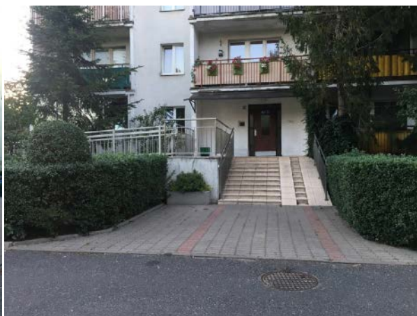
Fot. 6.12 Wejście do budynku 11-kondygnacyjnego wzniesionego w systemie szczecińskim na warszawskim Natolinie wyposażonego w zewnętrzną rampę. Budynek przy ul. Żabińskiego 9. Źródło: opracowanie własne
