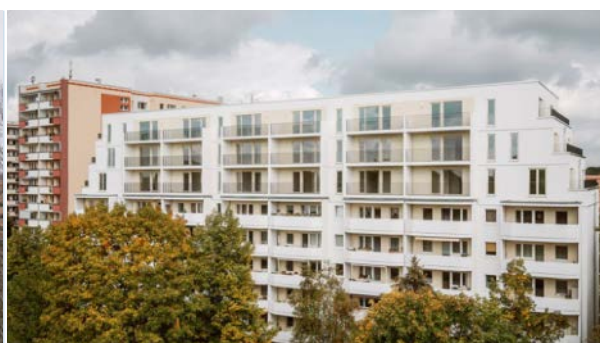
Fot. 5.4 Budynek przy ulicy Franz-Schmidt-Str. 11-17 po rozbudowie i modernizacji.
