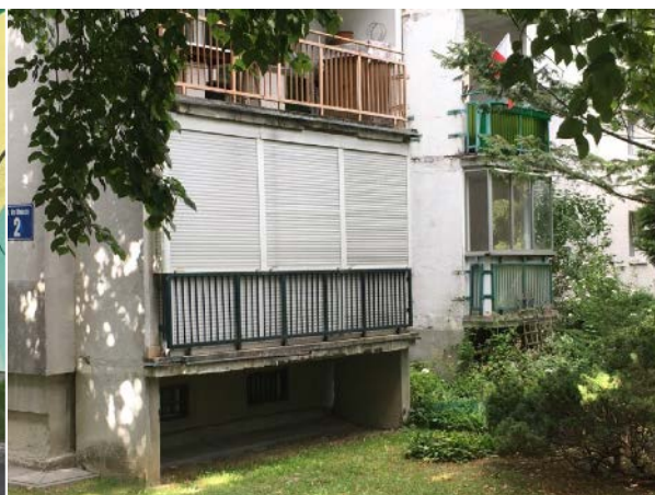
Fot. 6.27 Ochrona przeciwwłamaniowa. Budynek przy ul. Na Uboczu 2.
