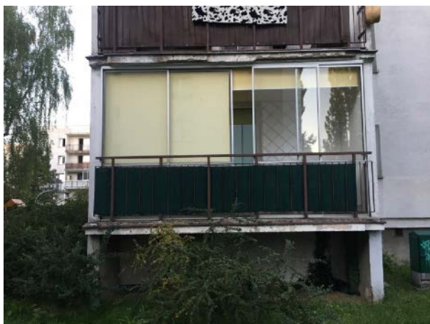
Fot. 6.24 Zabudowa balkonu wraz z ochroną przeciwsłoneczną w postaci rolet. Budynek przy ul. Małej Łąki 9.
