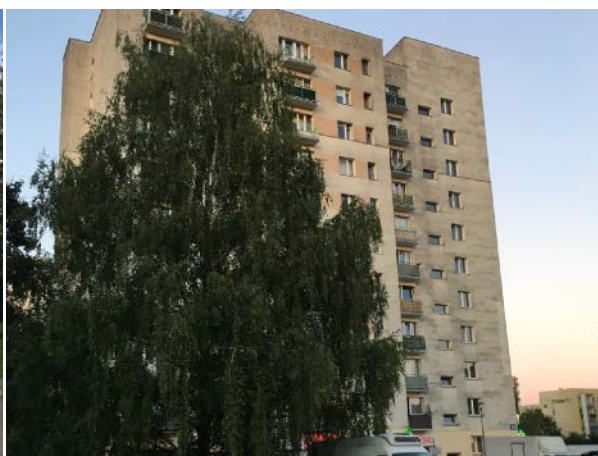
Fot. 6.2 - Elewacja budynku 11-kondygnacyjnego wzniesionego w systemie szczecińskim na warszawskim Natolinie. Budynek przy ul. Belgradzka 22.
