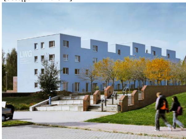
Fot. 3.30 Budynek mieszkaniowy wielorodzinny Haus 6 przy Stormstraße 14–28 w Leinefelde po modernizacji.
