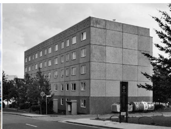
Fot. 3.29 Budynek mieszkaniowy wielorodzinny Haus 4 przy Büchnerstraße 26–40 w Leinefelde przed modernizacją.
