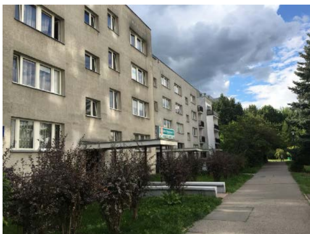
Fot. 6.1 - Elewacja frontowa z klatką schodową budynku 4-kondygnacyjnego wzniesionego w systemie szczecińskim na warszawskim Natolinie. Budynek przy ul. Na Uboczu 2.
