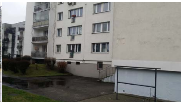
6.8 - Balkony francuskie. Budynek przy ul. Na Uboczu.
