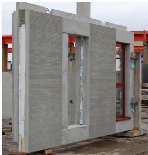
Fot. 3.6 MUF. Element prefabrykowany elewacji.
