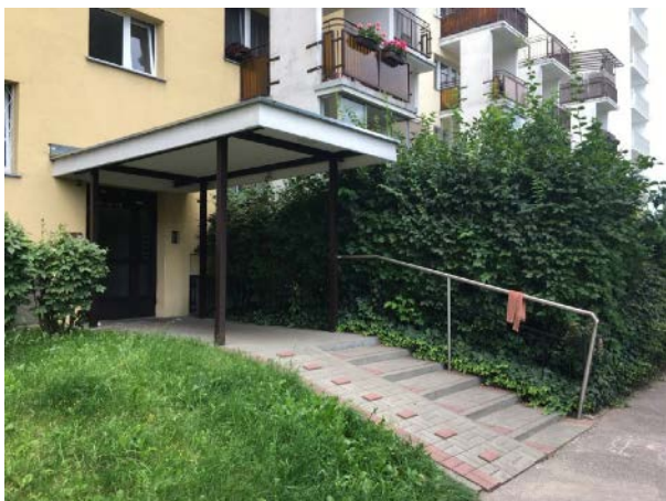
Fot. 6.30 - Wejście do budynku 4-kondygnacyjnego wzniesionego w systemie szczecińskim na warszawskim Natolinie. Budynek przy ul. Na Uboczu 22.
