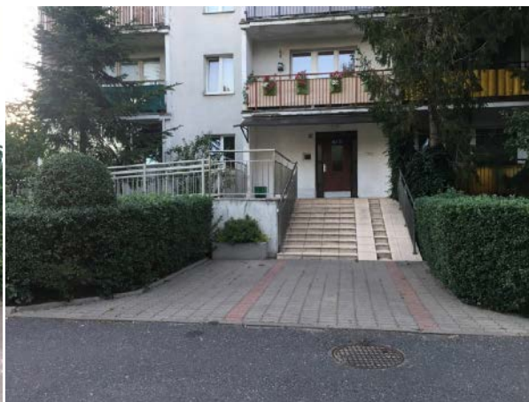
Fot. 6.31 - Wejście do budynku 11-kondygnacyjnego wzniesionego w systemie szczecińskim na warszawskim Natolinie wyposażonego w zewnętrzną rampę. Budynek przy ul. Żabińskiego 9.
