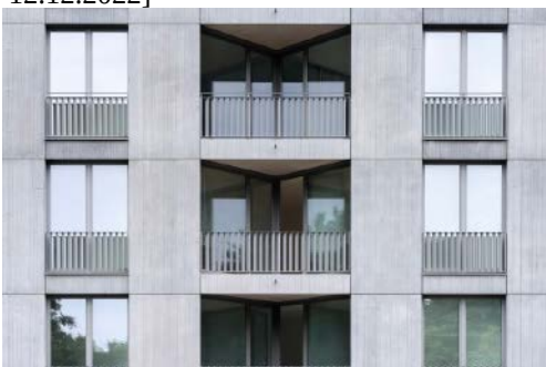
Fot. 3.5 Budynek mieszkalny H6 NEUE PLATTE.BERLIN przy Hochstrasse 6 w Berlinie. Detal elewacji.
