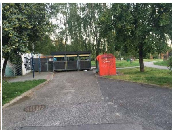
Fot. 6.29 Miejsce składowania odpadów przy ul. Żabińskiego.
