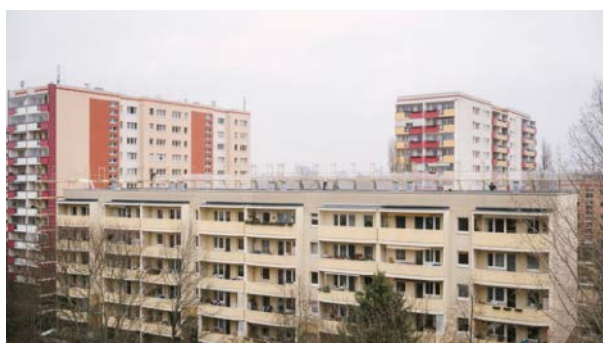
Fot. 5.3 Budynek przy ulicy Franz-Schmidt-Str. 11-17 przed rozbudową i modernizacją.
