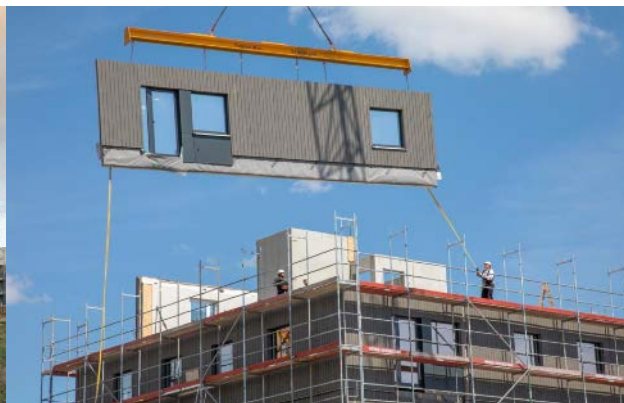
Fot. 3.11 Zespół budynków mieszkalnych UH – Urban Timber Construction przy Dolgenseestr. 32/33 z 2019 roku w Berlinie. Prefabrykowany element elewacji.
