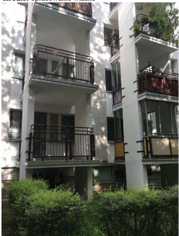
Fot. 6.5 - Balkony w budynku 4-kondygnacyjnym. Budynek przy ul. Na Uboczu 14. Źródło: opracowanie własne
