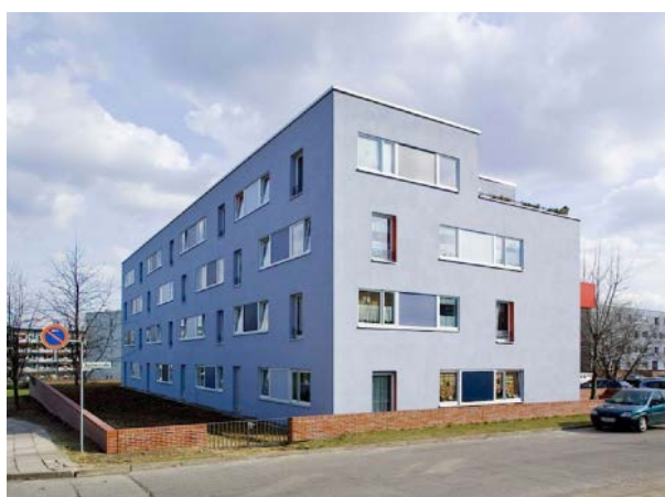
Fot. 3.28 Budynek mieszkaniowy wielorodzinny Haus 4 przy Büchnerstraße 26–40 w Leinefelde po modernizacji.
