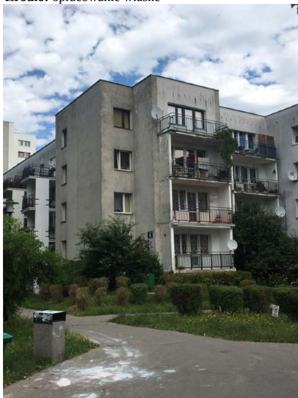
Fot. 6.6 - Loggie w budynku 4-kondygnacyjnym. Budynek przy ul. Na Uboczu 6. Źródło: opracowanie własne
