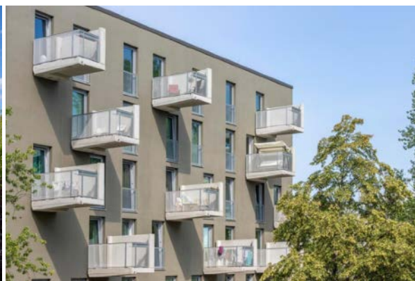
Fot. 5.6 Paul-Zobel-Apartments przy Paul-Zobel-Str. 10/10A. Detal elewacji.
