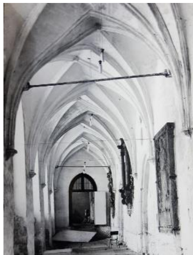
Rys. 207. Widok północnego krużganka, Elbląg, 1976. Fig. 207. View of the northern cloister, Elbląg, 1976.
