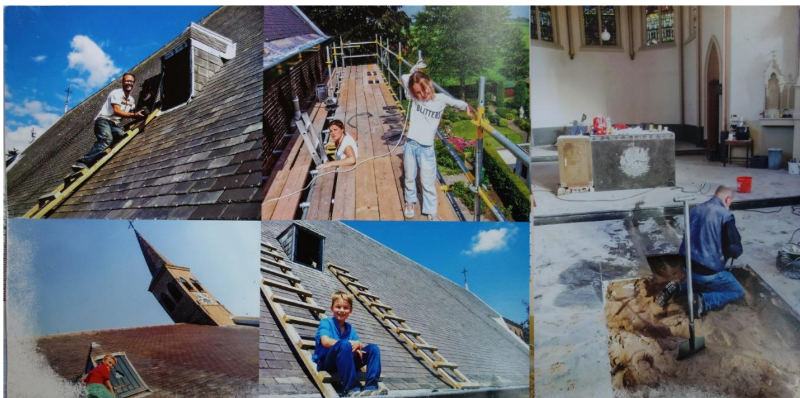
Rys. 119. Zdjęcia wykonane podczas prac renowacyjno-budowlanych kościoła św. Willibrorda, Hooze Zwaluwe. Fig. 119. Photos made during the renovation and construction works of the church of St. Willibrord, Hooze Zwaluwe.
