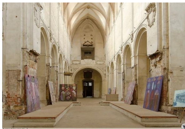
Rys. 220. Kościół poklasztorny pw. Wniebowzięcia NMP, Lubiąż, 2014.
