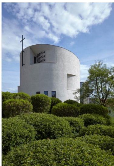
Rys. 31. Kościół pw. św. Wacława, Sazovice, Czechy, 2017. Fig. 31. The church of St. Wenceslas, Sazovice, Czech Republic, 2017.
