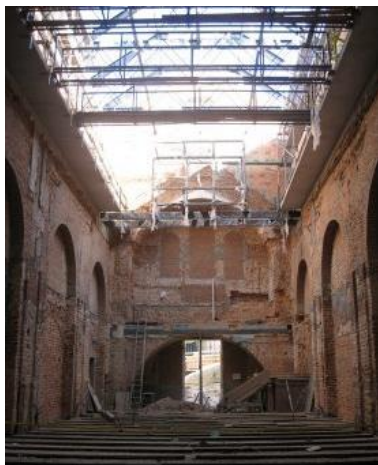
Rys. 212. Wnętrze dawnego kościoła sióstr wizytek, Lublin, 2009. Fig. 212. The interior of the former church of the Sisters of Visitation, Lublin, 2009.
