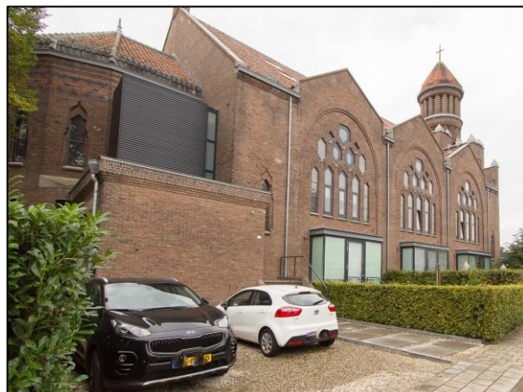
Rys. 172. Wielorodzinny budynek mieszkaniowy, Waalwijk. Widok na ścianę boczną, 2015.
