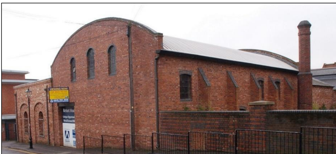
Rys. 19. Adaptacja dawnego budynku gazowni (1822) na kościół anglikański (2014), Birmingham, Wielka Brytania.
