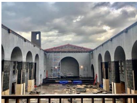
Rys. 228. Kościół pw. Matki Bożej Nieustającej Pomocy, Rotterdam. Rozbiórka dachu, 2020. Fig. 228. Church of Our Lady of Perpetual Help, Rotterdam. Roof demolition, 2020.
