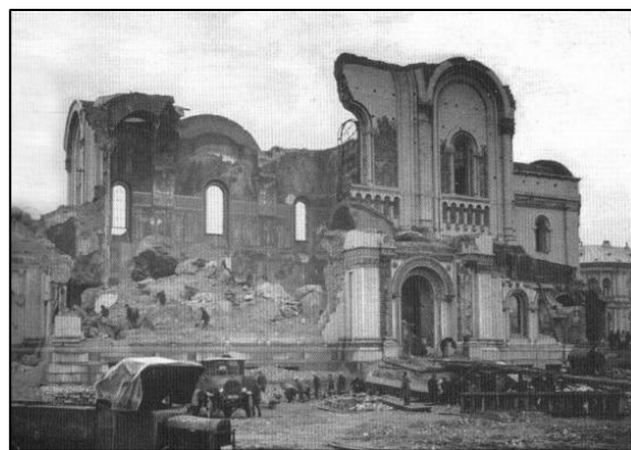
Rys. 17. Rozbiórka soboru pw. Aleksandra Newskiego w Warszawie, 1926. Fig. 17. Demolition of the Cathedral of Alexander Nevsky, Warsaw 1926.
