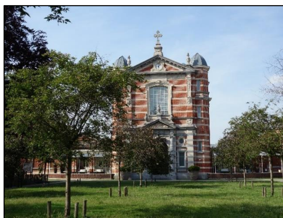
Rys. 133. Restauracja The Jane w dawnej kaplicy szpitalnej, Antwerpia, 2019. Fig. 133. Restaurant The Jane in the former hospital chapel, Antwerp, 2019.
