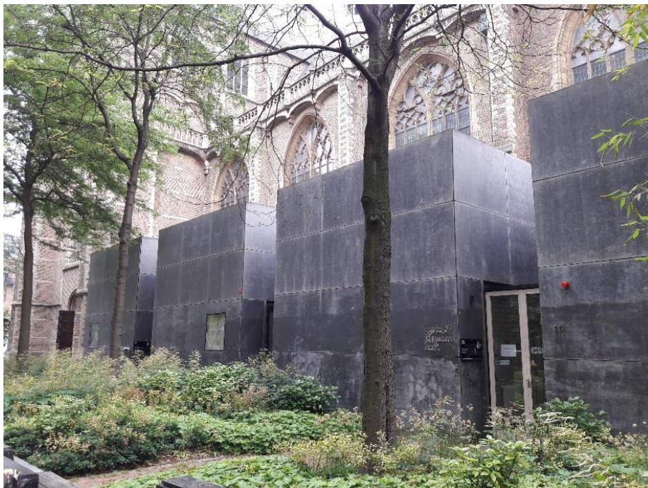
Rys. 72. Centrum kultury Laurenskerk, Rotterdam. Nowo zbudowane pomieszczenia biurowe, w kształcie sześcianów, nawiązują do znajdujących się na tym miejscu w przeszłości kamieniczek i budynków gospodarczych, 2019.
