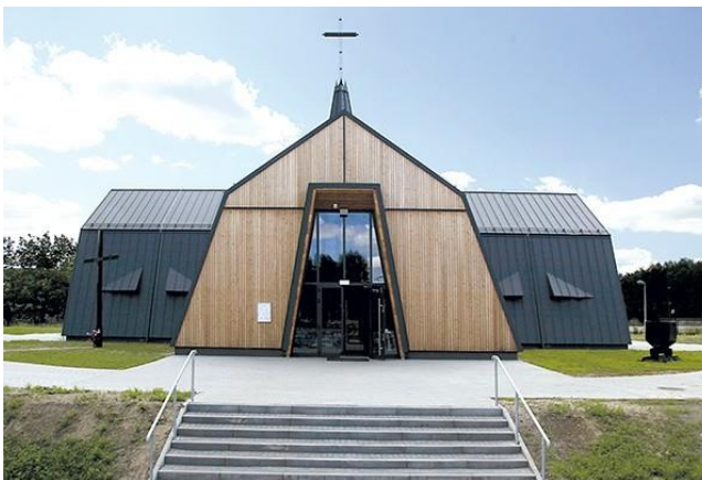
Rys. 216. Kościół pw. św. Józefa Robotnika, Bytom–Stroszek (Vitor), 2015. Arch. Jan Rabiej. Fig. 216. Church of St. Josef, Bytom – Stroszek (Vitor), 2015. Arch. Jan Rabiej.
