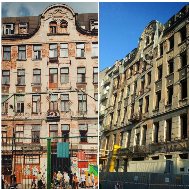
Rysunek 106. Zdjęcie kamienicy po nabyciu przez Magmillon oraz tuż przed rozpoczęciem prac budowlanych.
