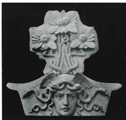
Rysunek 35. Detal znajdujący się nad oknami I-go piętra kamienicy przy ul. Marszałkowskiej 129
