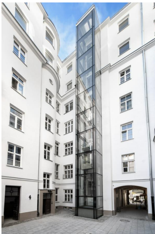
Rysunek 94. Przeszklona winda w kamienicy przy ul. Mokotowskiej 40 w Warszawie. Źródło: https://ipeco.pl/rewitalizacja/
