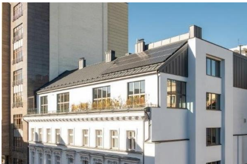
Rysunek 98. Panele fotowoltaiczne na dachu kamienicy przy Hożej 42.
