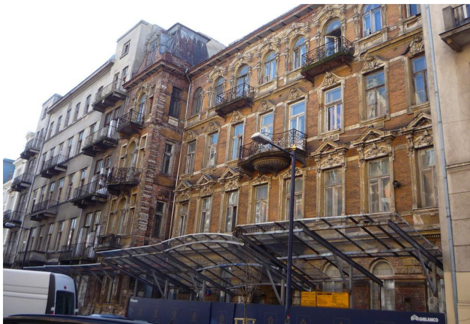
Rysunek 48. Elewacja kamienicy przy ul. Foksal 13/15 w Warszawie - przed odnową.
