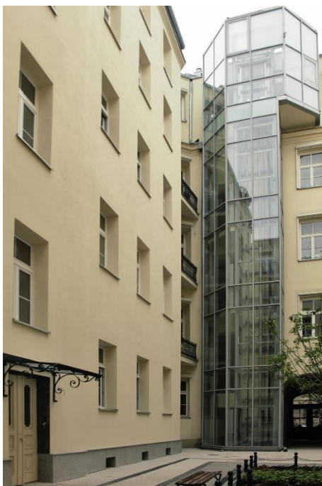
Rysunek 95. Przeszklona winda w kamienicy przy ul. Wilczej 22 w Warszawie. Źródło: http://realco.pl/wilcza22/galeria/wilcza-22-kamienica-w-podworzu-1894-2015
