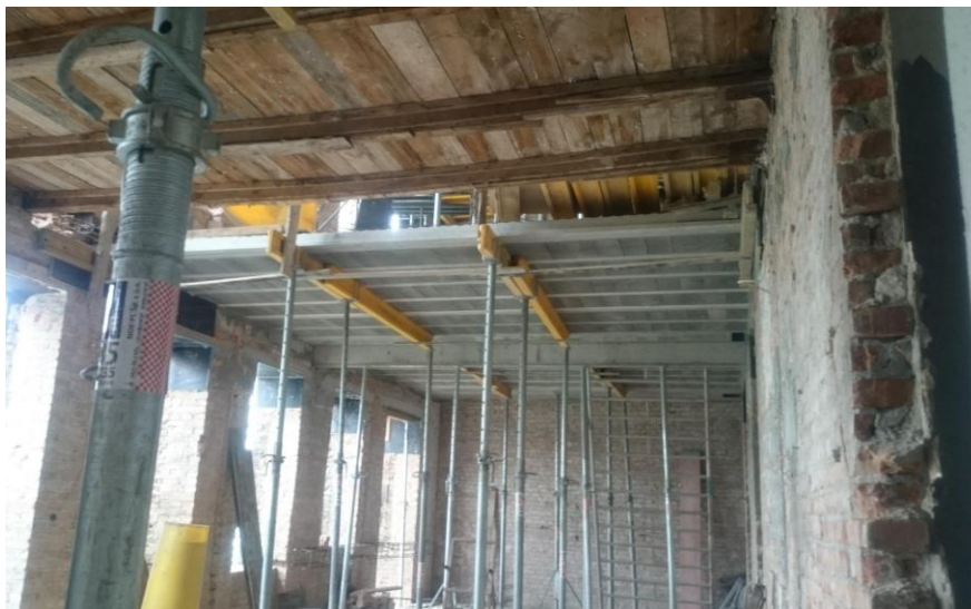
Rysunek 112. Prace związane z szalowaniem stropów nad 3 piętrem w oficynach.
