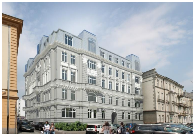
Rysunek 45. Kamienica przy ul. Smolnej 40 zaadaptowana na funkcję biurową i hotelową. Opis: Dach został odbudowany, uzupełniono go o całoszklane lukarny. Na tyłach kamienicy została dobudowana oficyna o nowoczesnym charakterze, z w pełni przeszkloną elewacją. Źródło: http://www.kulczynski.com/pl/41/Smolna
