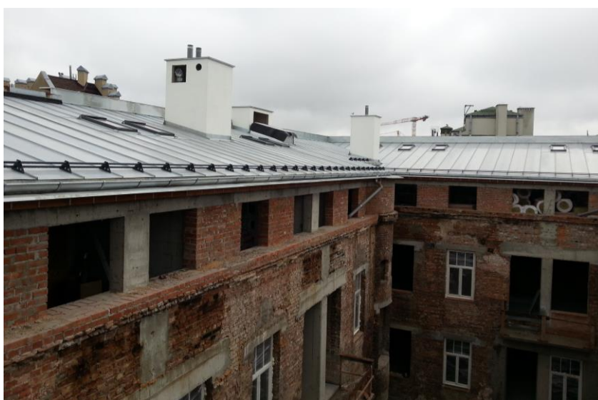
Rysunek 114. Elewacja na poziomie nowopowstałej kondygnacji.
