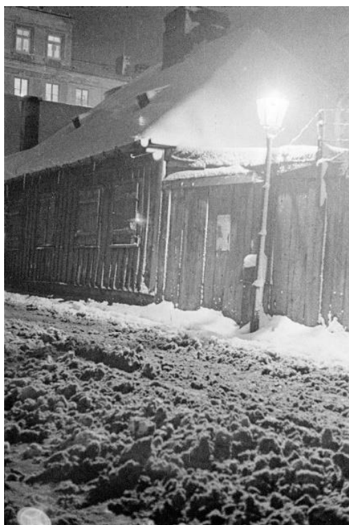
Rysunek 14. Kontrast pomiędzy drewnianą zabudową na posesji Topiel 1 (róg Tamka) oraz kamienicą (w tle) przy Tamce 23.
