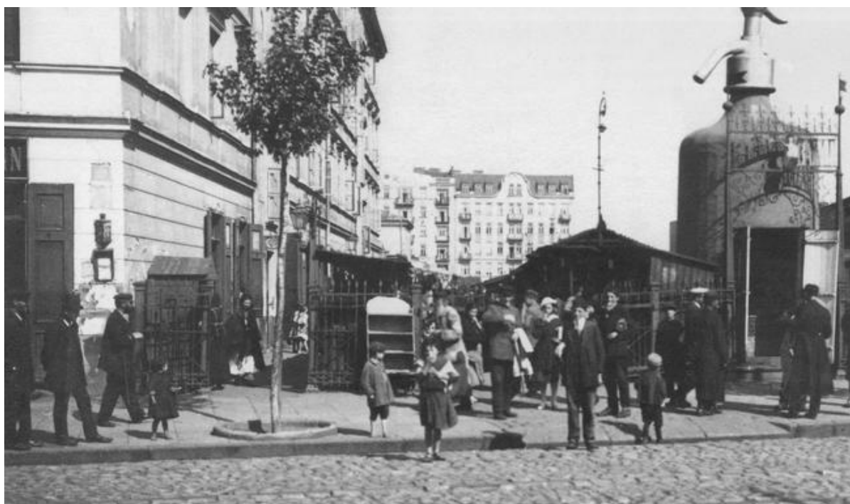
Rysunek 104. Zdjęcie wejścia na bazar Różyckiego od strony ul. Targowej. W tle widoczna kamienica przy ul. Brzeskiej 18.
